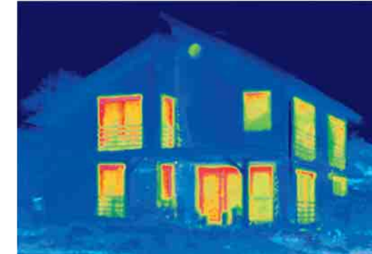
Infrarotaufnahmen, Thermografien, zeigen deutlich, wo ein Haus unkontrolliert Energie verliert. Rot bedeutet Wärme und damit hohen Energieverlust.
